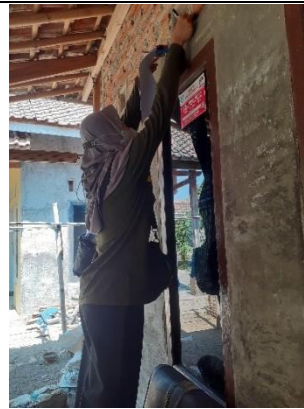
Pengukuran Lubang Ventilasi
